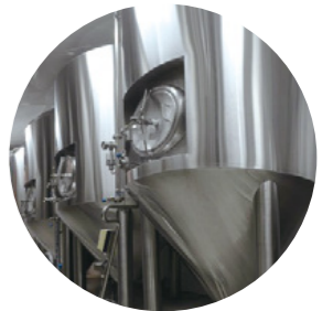
CIP洗剤移送・循環ライン
