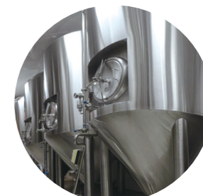
CIP洗剤移送・循環ライン
